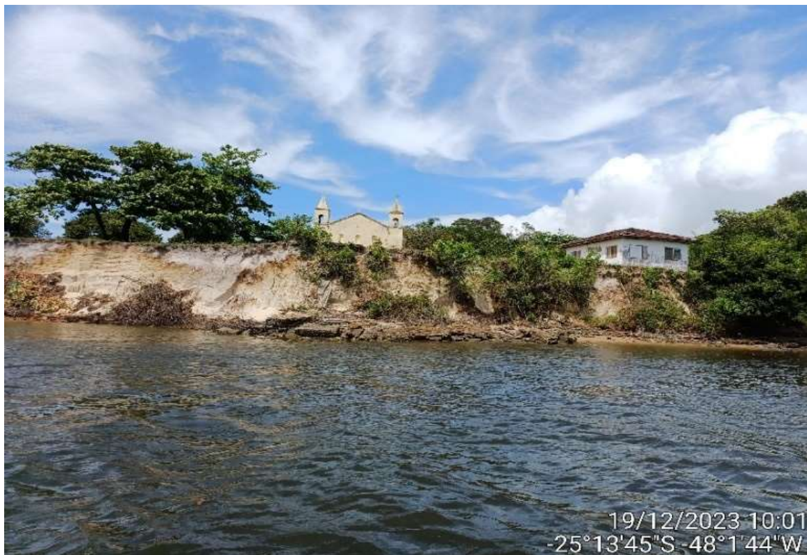
Figura 7 - Processo Erosivo de Encosta - Ararapira
