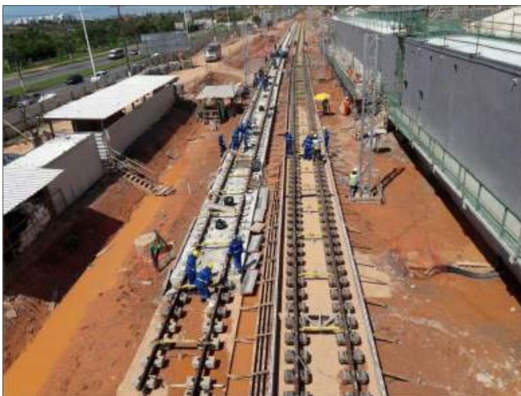
Figura: Montagem da grade ferroviária para concretagem tipo Top-Down
