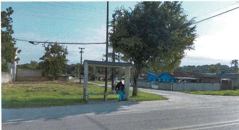
Figura 16 - Falta de calçamento e confusão entre acostamento e calçamento na PR-412 em Pontal do Paraná
