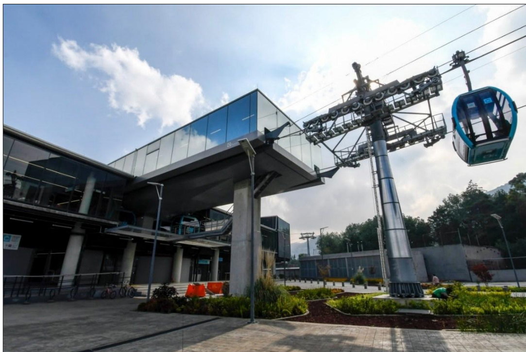
Imagem 2 – Estação Cuauhtémoc, localizada no extremo norte da Linha 1 do Cablebús na Cidade do México.
